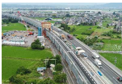
過年度の東名阪道リニューアル工事の状況
