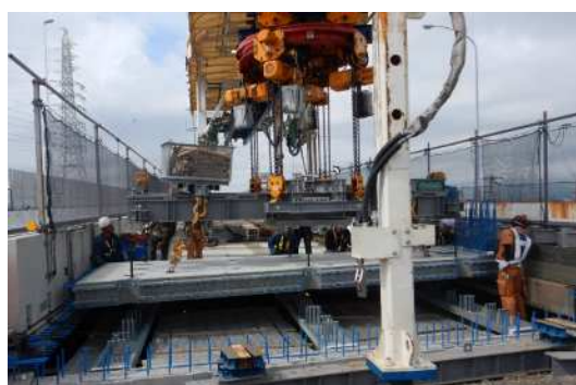
コンクリート床版の取替(イメージ)
