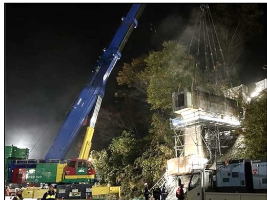
【大型クレーンによる撤去作業】
