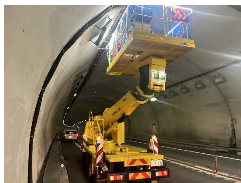
＜トンネル内設備点検状況＞
