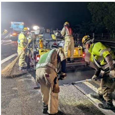
舗装補修工事(イメージ)
