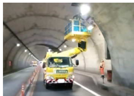
＜トンネル内設備の補修作業状況＞
