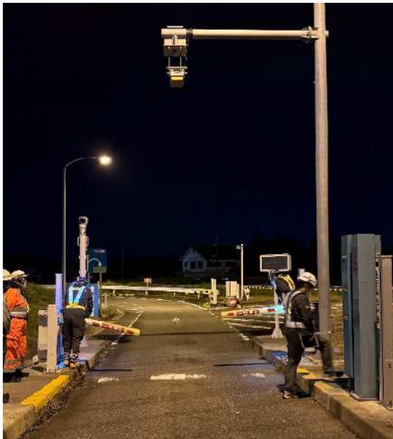
開閉バー 確認作業状況
