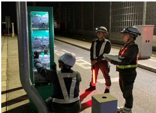
簡易発券機の現地作業状況
