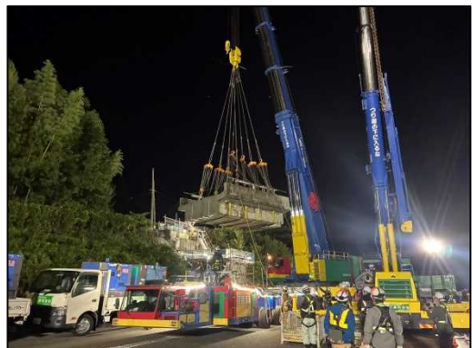
【大型クレーンによる撤去作業】
