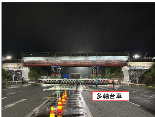
【多軸台車による撤去作業】
