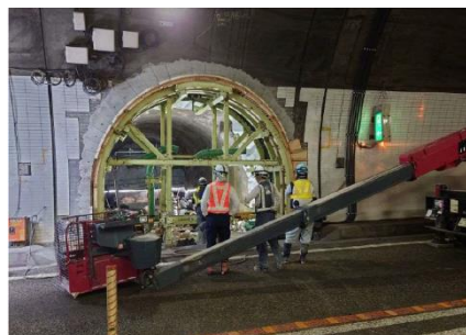
避難連絡坑拡幅工事(4車線化工事)
