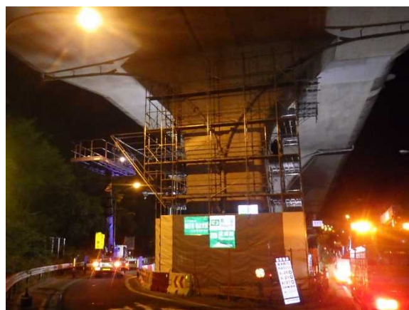
施工状況(足場設置)
