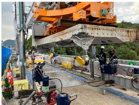
コンクリート床版の撤去(イメージ)
