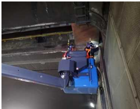
制水ゲートの設備点検
