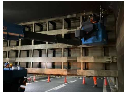
制水ゲートの設備点検
