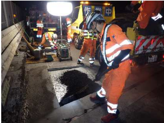
舗装補修工事(施工中)
