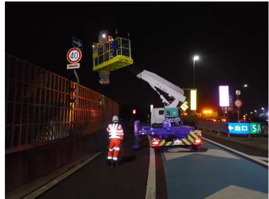
遮音壁点検(点検中)
