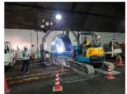
避難連絡坑拡幅工事
