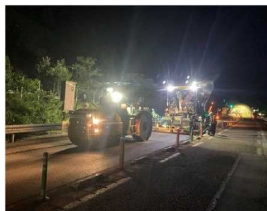
舗装補修工事
