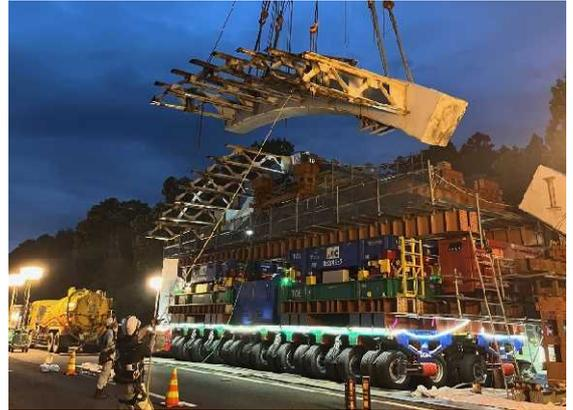
施工中（構造物の撤去・分割作業）
