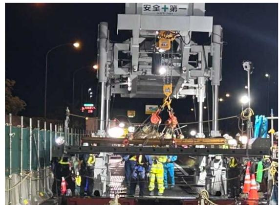
施工中(新設床版の設置)
