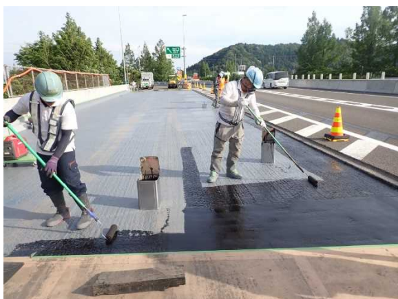
施工中(床版防水工)
