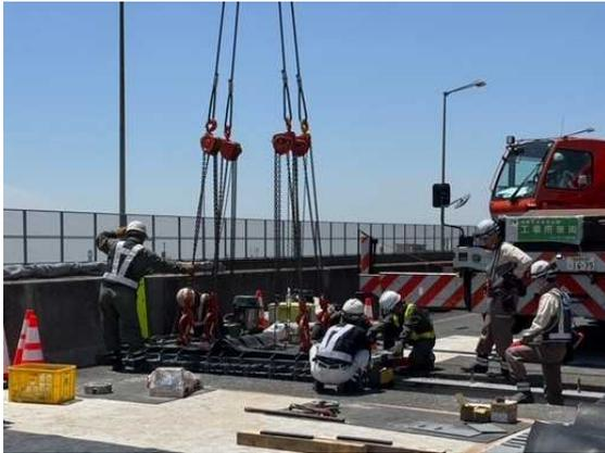
施工中(伸縮装置の設置)
