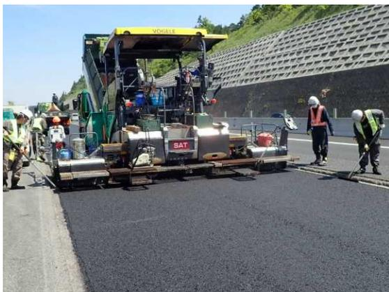
施工中(新しい舗装の舗設)
