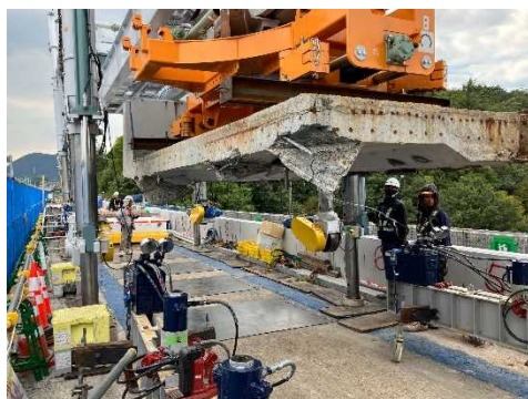
コンクリート床版の撤去(イメージ)
