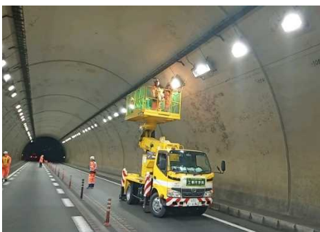
<トンネル照明設備の点検状況>
