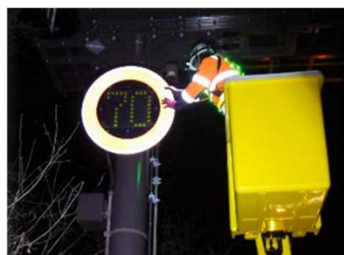
<設備点検(速度規制標識)>
