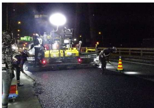
施工中(新しい舗装の舗設)
