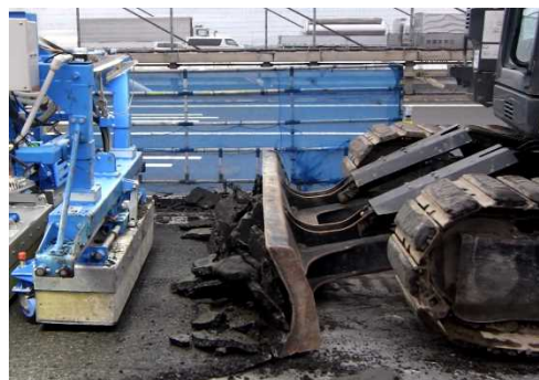
施工中(既設舗装の撤去)
