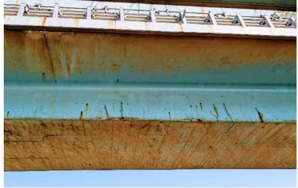
老朽化した橋げた下面の損傷状況
