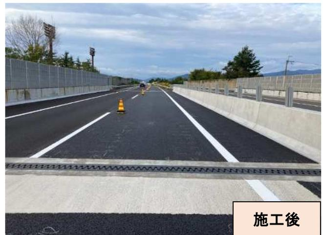
○布市橋（富山 IC～立山 IC）：老朽化した橋梁のコンクリート床版を新しい床版に取り替える工事
