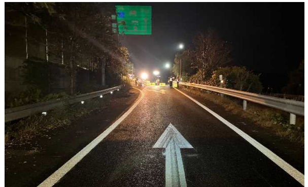
屏風山 PA(施工後)
