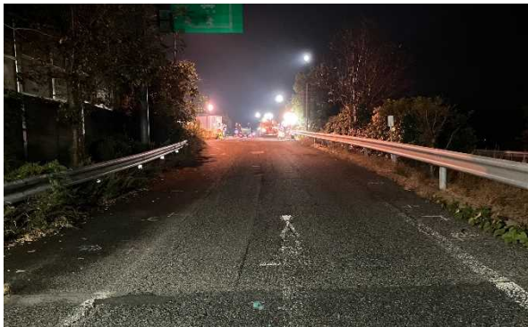
屏風山 PA(施工前)
