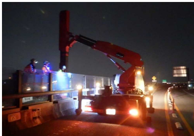
遮音壁の点検をおこないました
