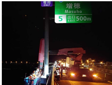
道路標識の点検をおこないました
