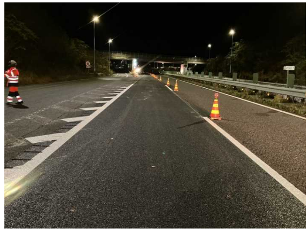
小黒川 PA 上り 入口付近(施工後)
