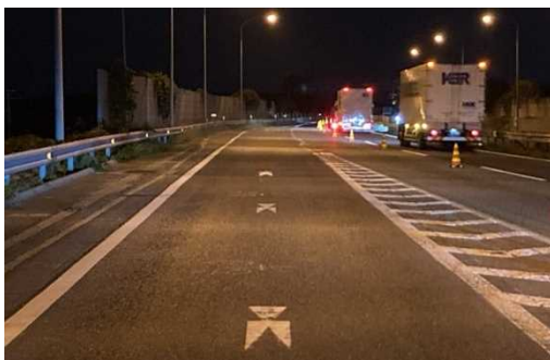
鈴鹿 IC(施工前)
