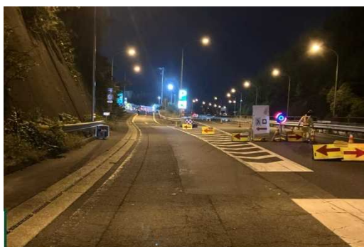
大山田 PA(施工前)
