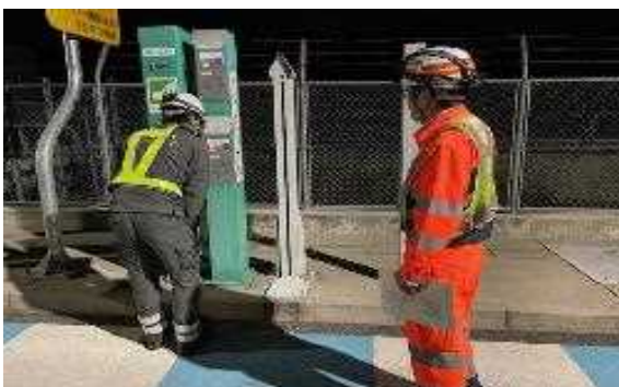
レーン機器の動作試験状況
