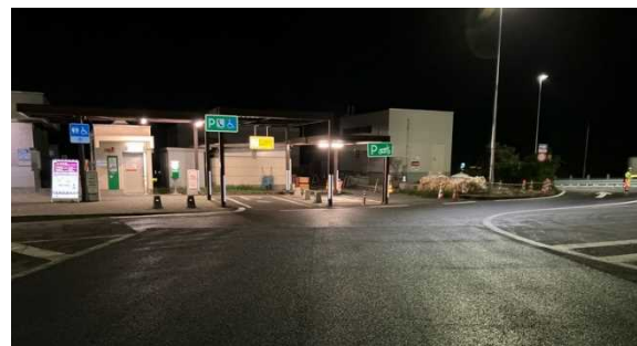
神坂 PA(施工後)
