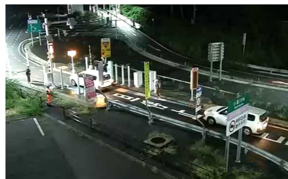
レーン機器との走行試験状況
