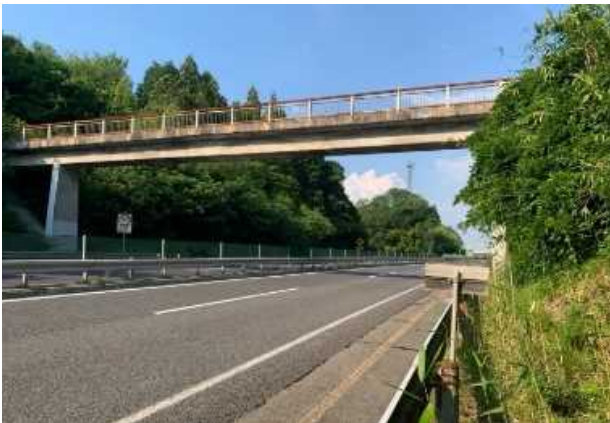
撤去した白山跨道橋(瑞浪市管理)
