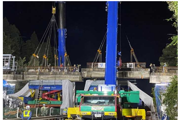
大型クレーンによる撤去作業状況
