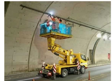
トンネル点検状況
