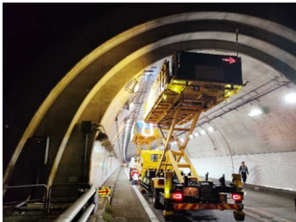
トンネル内設備点検
