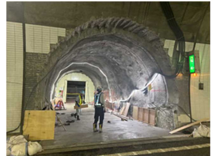
避難連絡坑拡幅工事
