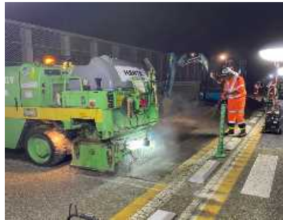
舗装補修工事
