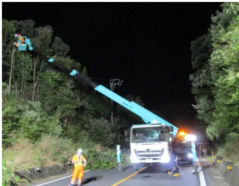
枯れた木の伐採作業
