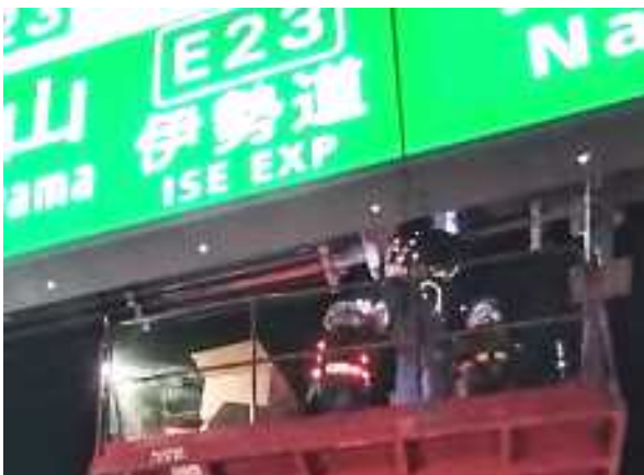
ETC 無線通信専用アンテナ(施工中)
