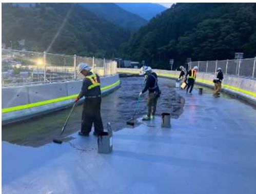
床版防水の施工状況
