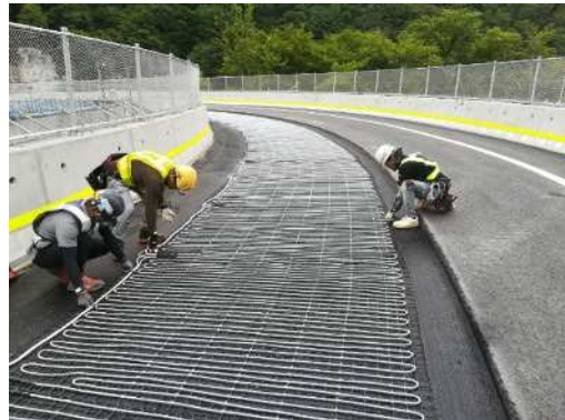
融雪設備の設置状況
