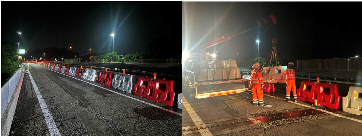
防護柵などの復旧工事を実施しました
