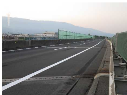
施工前（鎖川橋）
