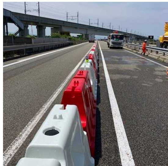
事故で破損した仮設防護柵の取替を行いました
