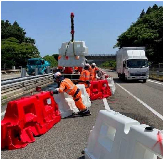
事故で破損した仮設防護柵の取替を行いました
