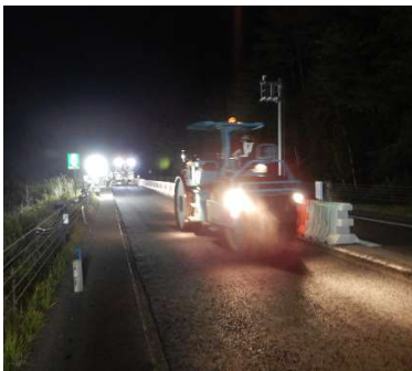
傷んだ舗装の補修工事をおこないました
