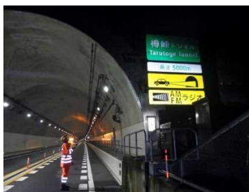
トンネル標識などの点検をおこないました
