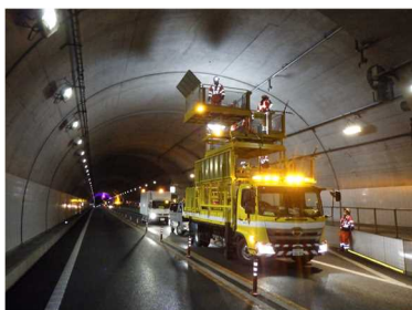
トンネルの覆工コンクリートの点検をおこないました
