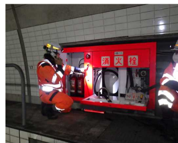
トンネル非常用設備などの点検をおこないました
