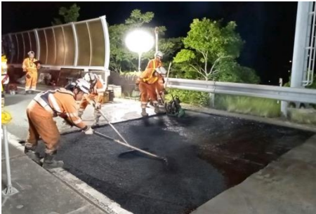
舗装補修工事
