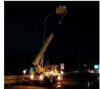
道路照明設備構造検査
