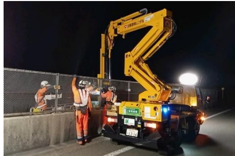
落下物防止柵補修工事
