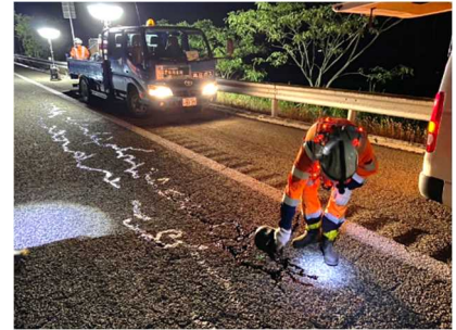
舗装補修工事
