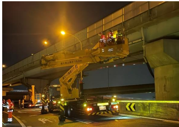
橋梁の点検状況
