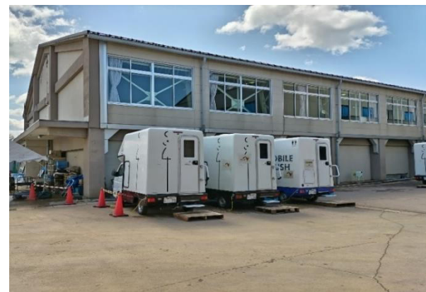
トイレカー 輪島中学校(輪島市)
