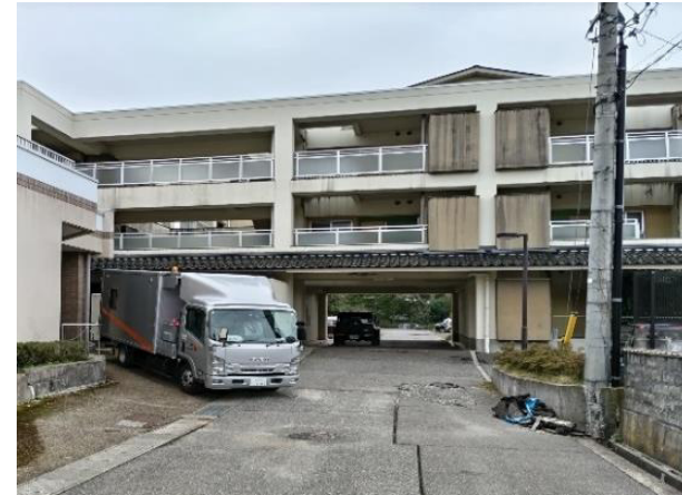
バイオトイレカー ふれあいプラザ二勢 (輪島市)
