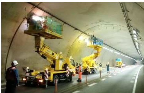
<トンネル照明設備点検>
