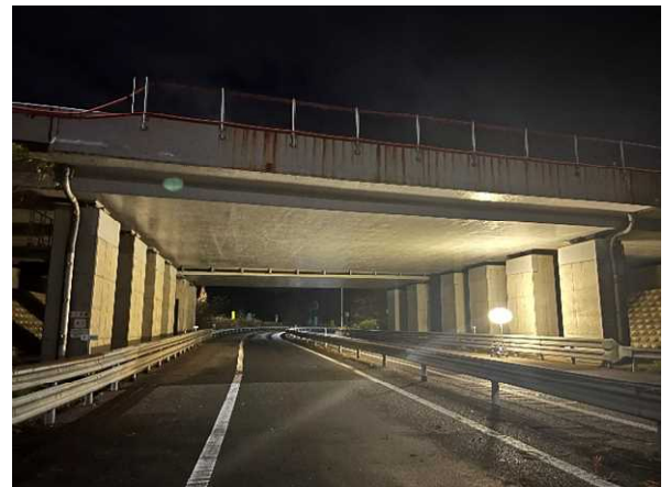
作業完了状況
