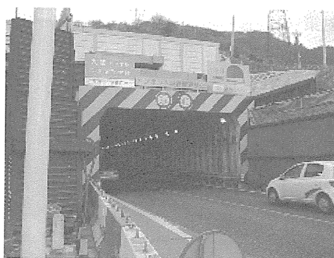
図 6.6 坑口車高制限予告用標識の例
