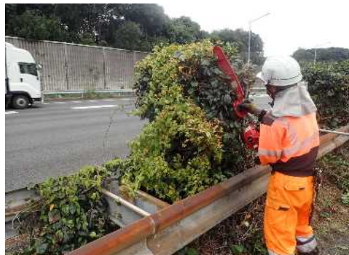
道路維持作業(樹木剪定)状況
