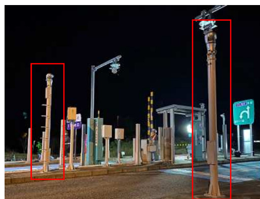
工事後(カメラ改造後)
