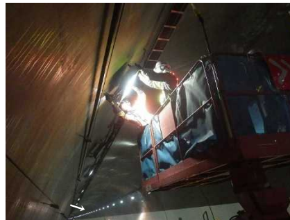
トンネル照明設備などの点検をおこないました
