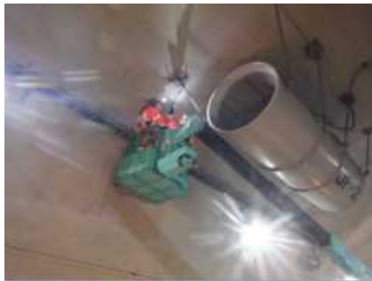
トンネル換気設備などの点検をおこないました
